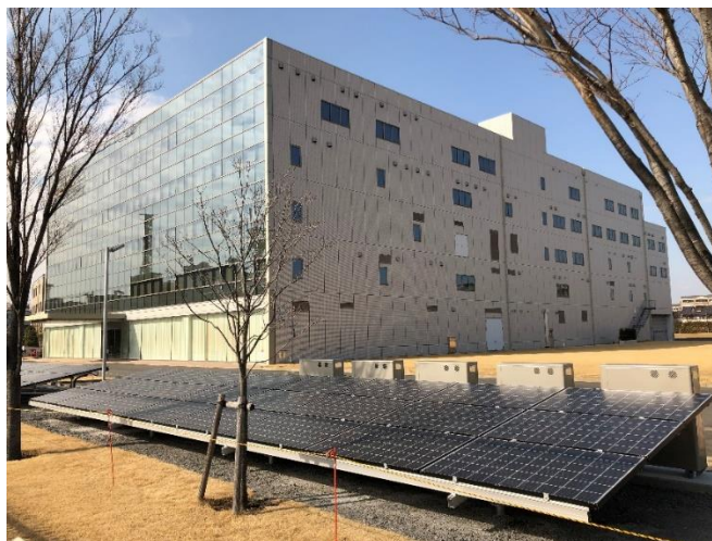
Testgelände am Yokohama Nakayama Firmensitz
